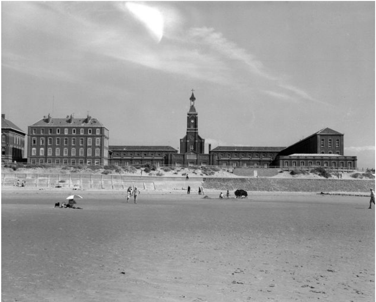
Corps de logis principal, élévation antérieure donnant sur la plage, vue générale prise de face.
