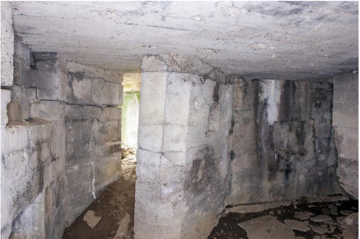
Vue intérieure, entrée en chicane ouest
