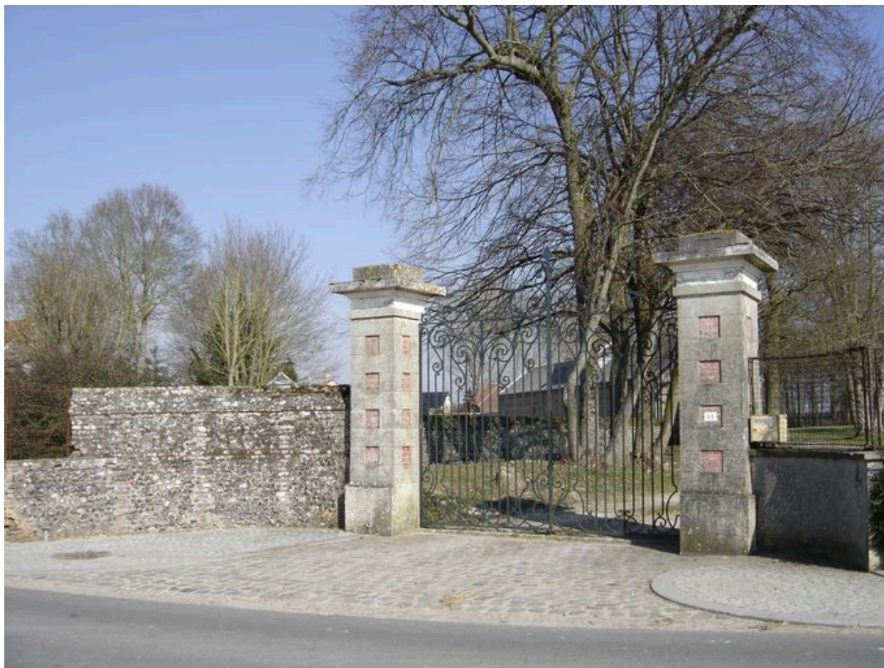
Vue du portail d'entrée sur la rue principale de Noyelles.
