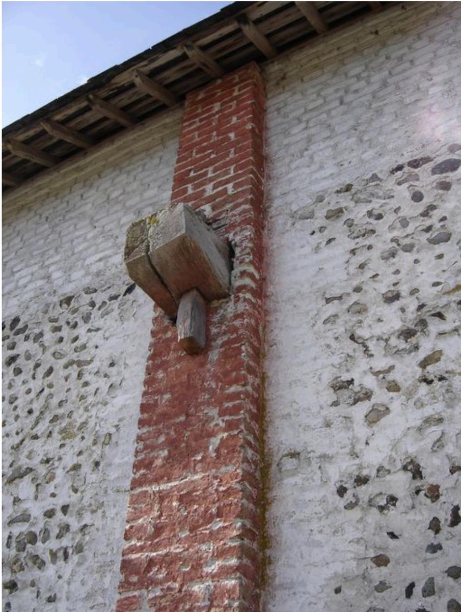
Détail d'un tenon d'ancrage.
