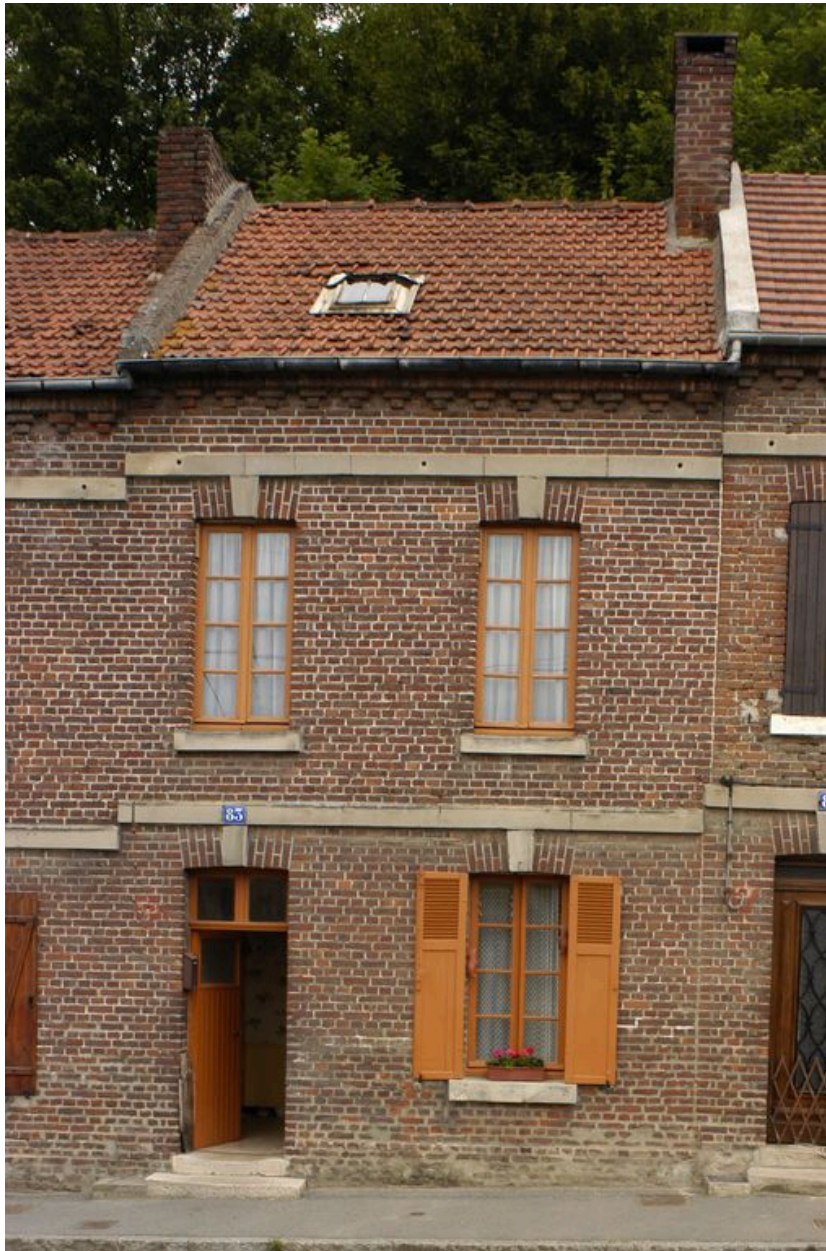
Vue de la façade sur rue d'un des logements du second groupe d'habitations.
