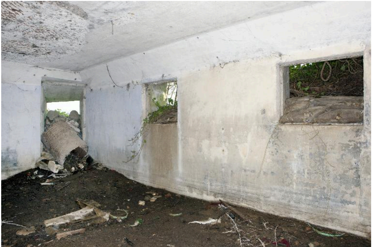
Intérieur de l'édifice vers le nord-est
