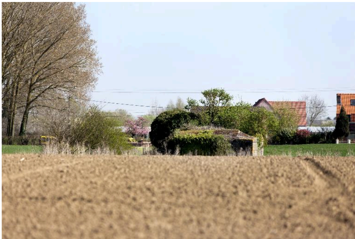
Vue générale, vers le nord-est. Au premier plan, le bâtiment A
