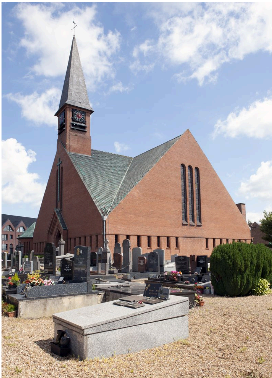
Vue extérieure du flanc droit.
