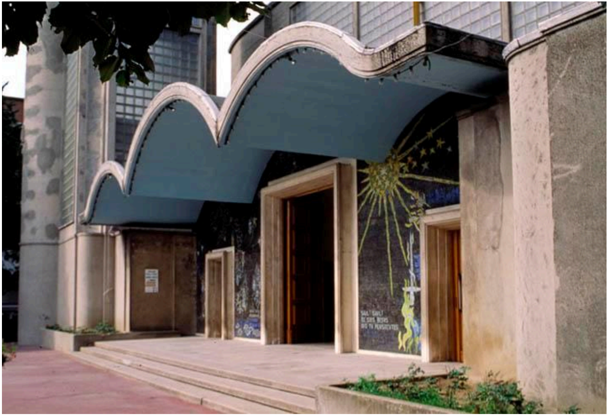
Détail du porche.
