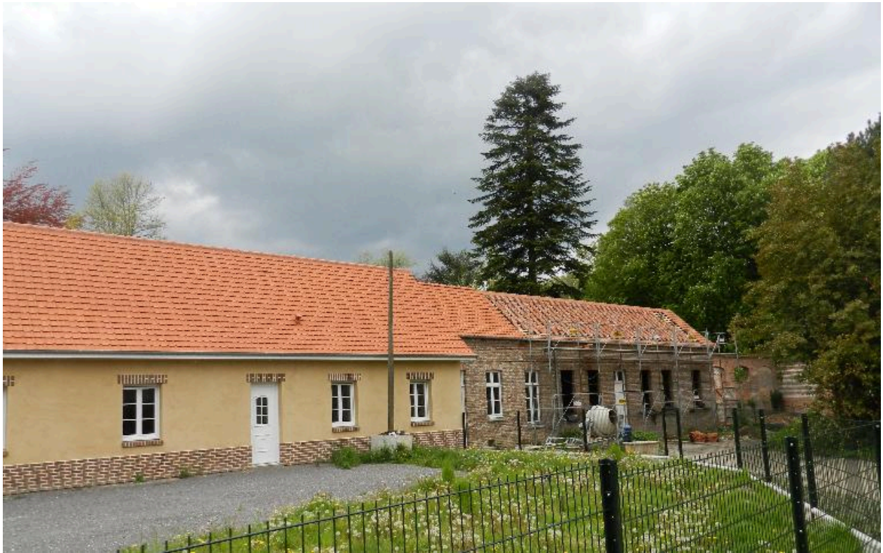
Vue de situation à refaire
