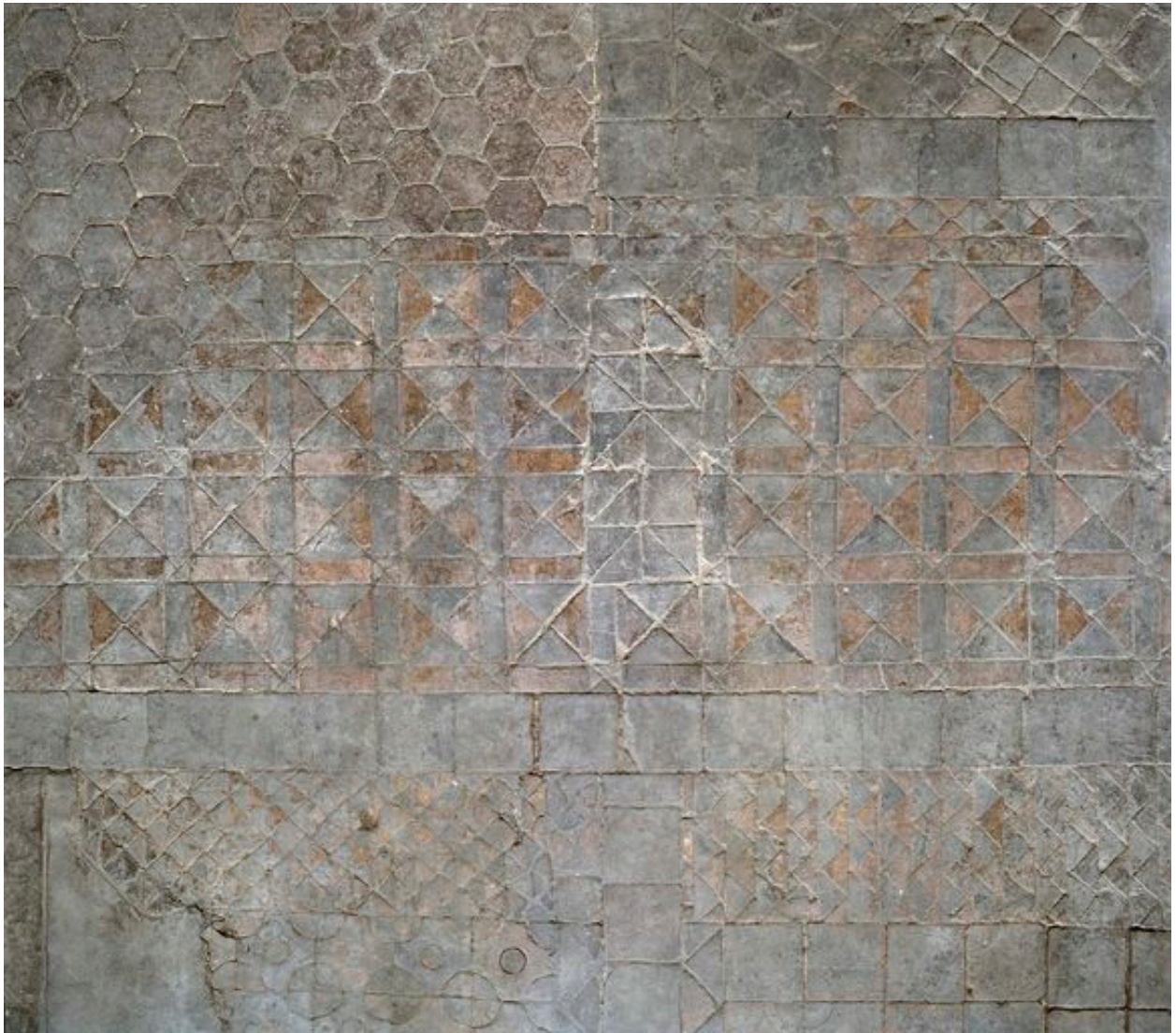
Détail du carrelage.
