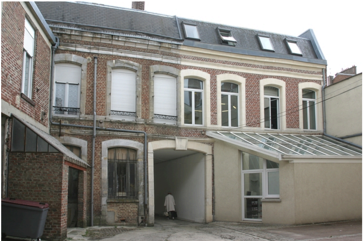
Façade postérieure des anciens logements patronaux.
