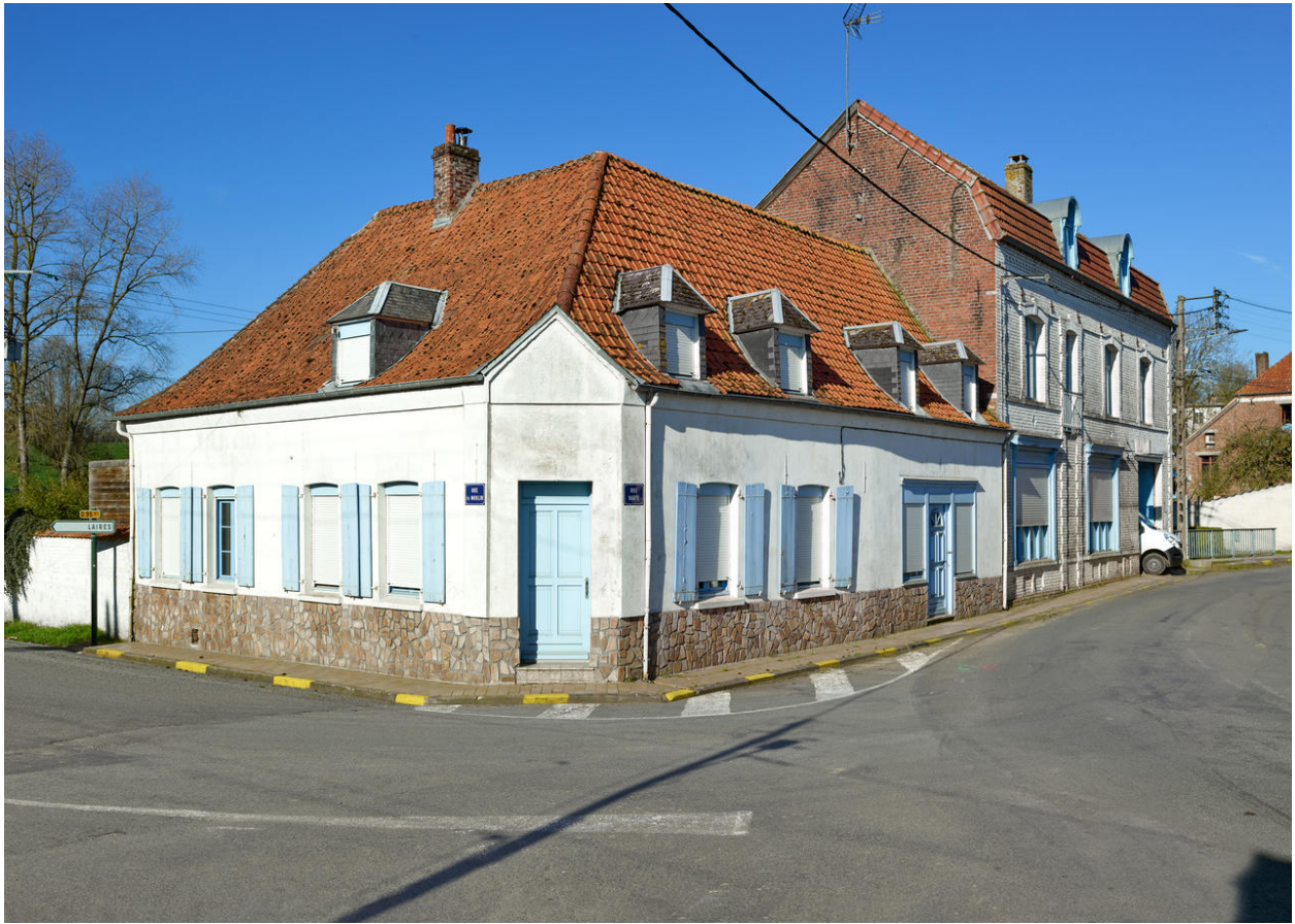
Vue générale depuis la place.
