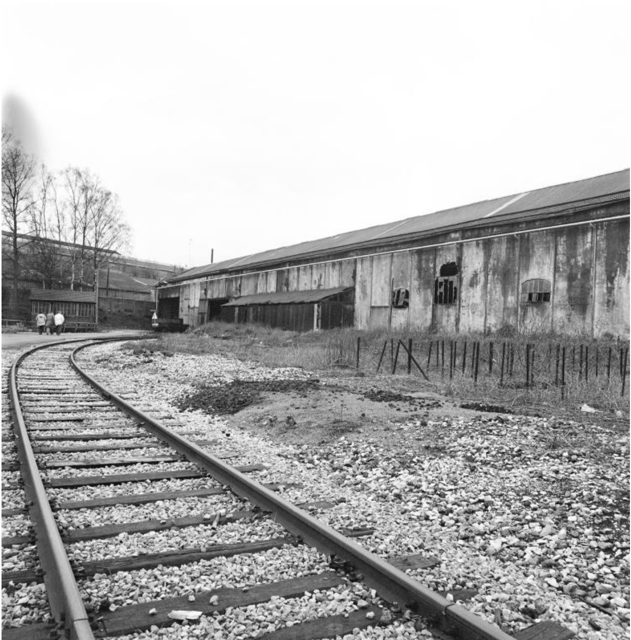
Ateliers, élévation est (usine B).
