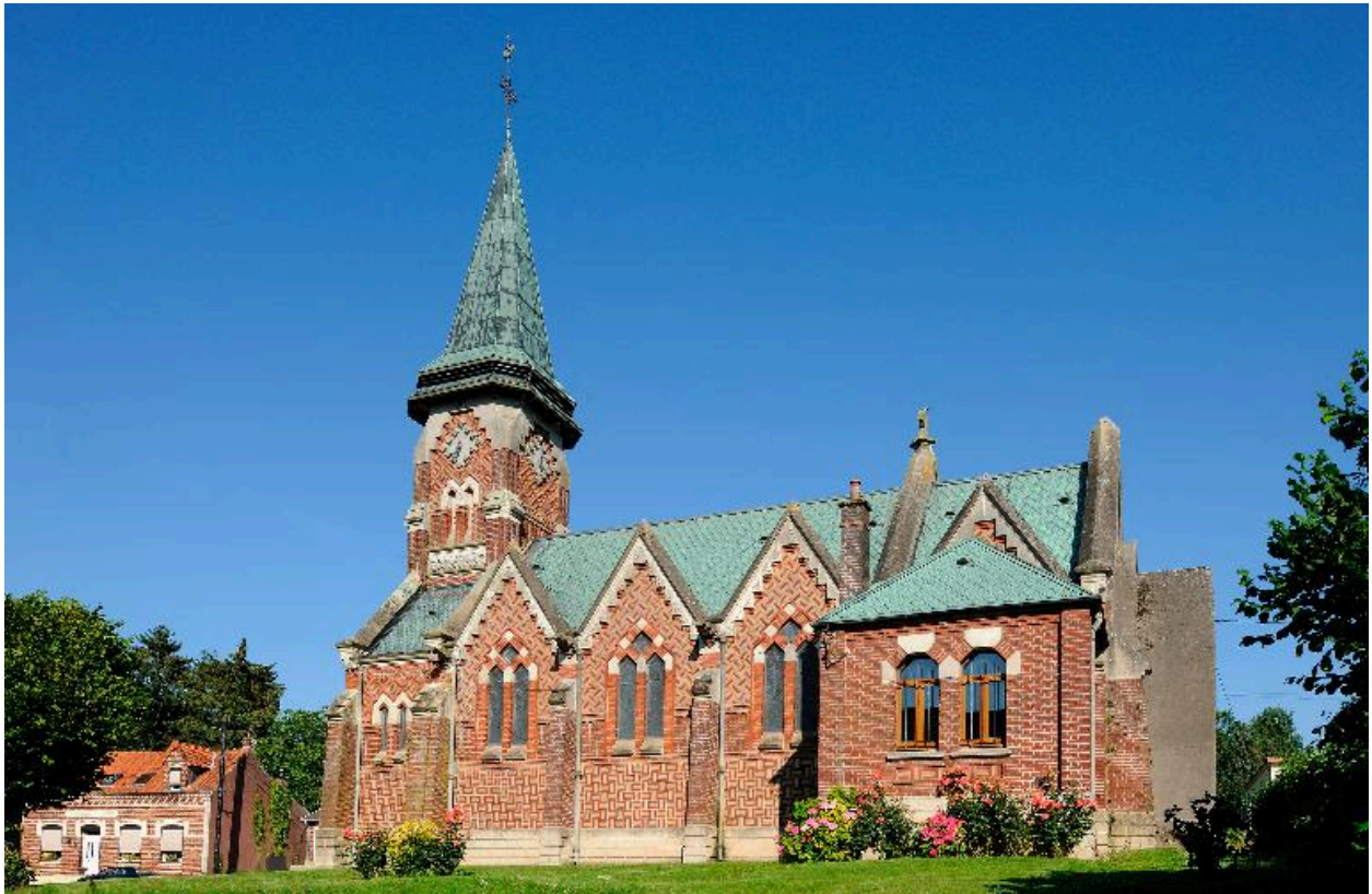
Vue de la façade sud
