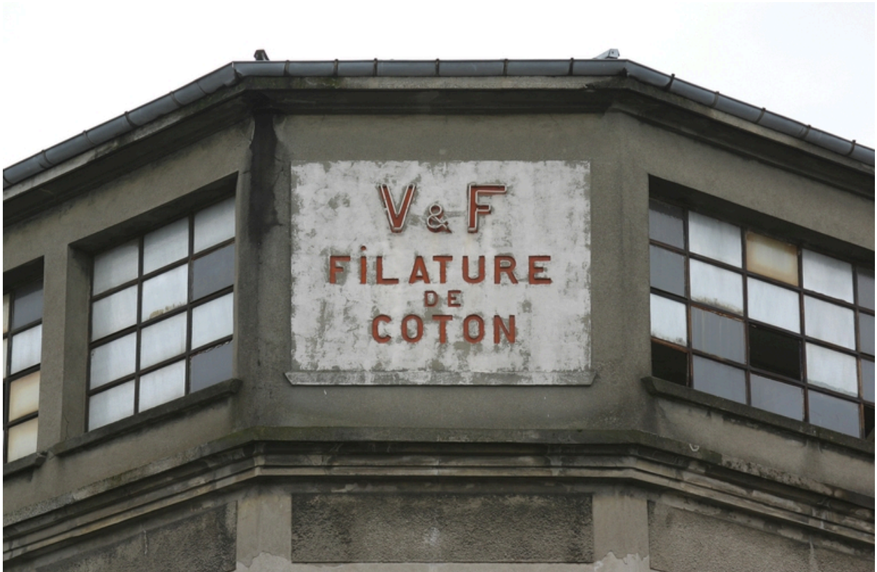
Façade de l'usine : détail.
