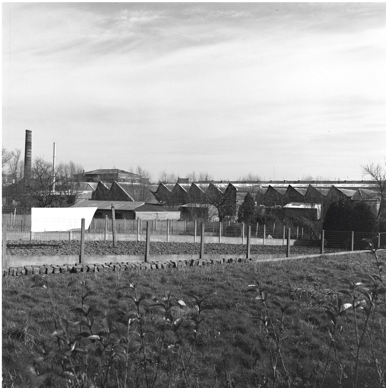
Vue générale prise vers le nord-est.
