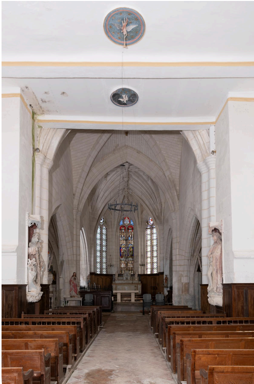
Vue générale vers le chœur.
