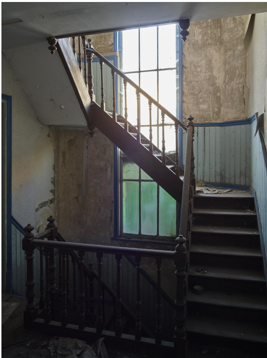
Bureaux : cage d'escalier.
