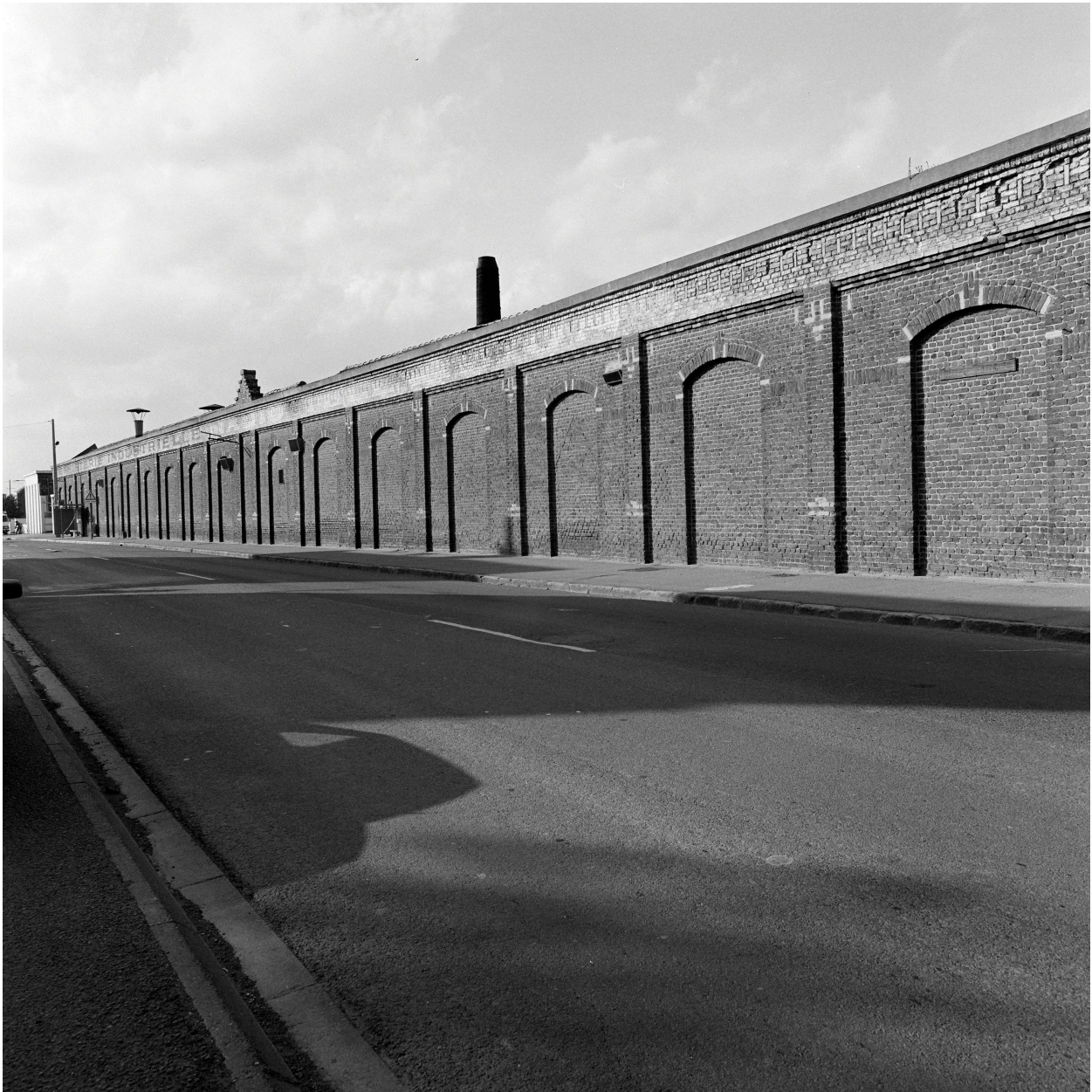
Atelier de fabrication. Élévation sur rue.
