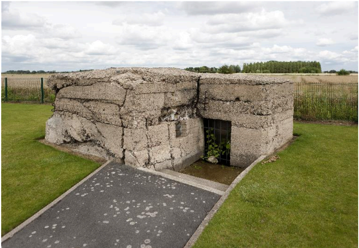
Casemate (f), vers le nord-est
