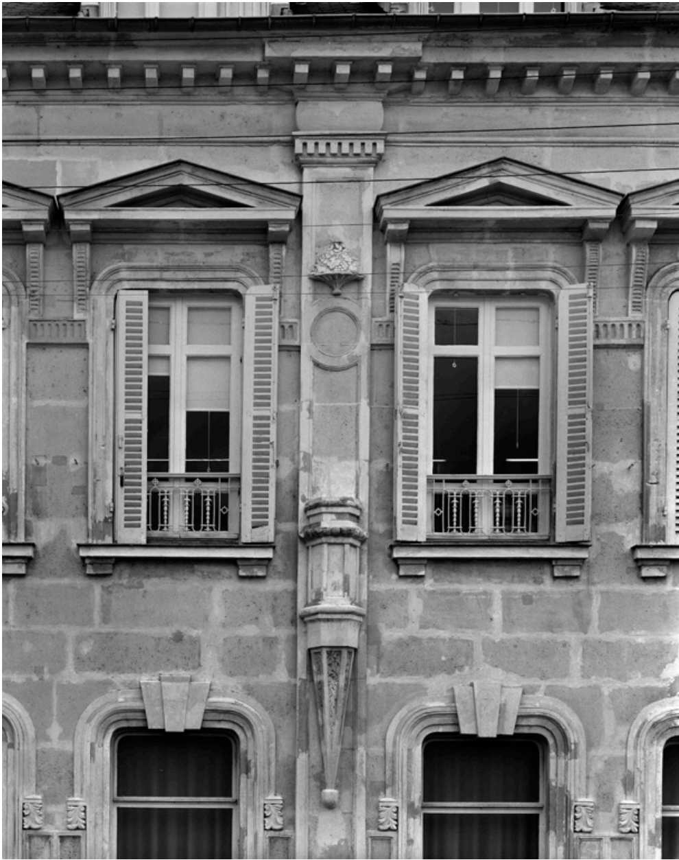
Façade sur la place des Etats Unis : vue du premier étage.
