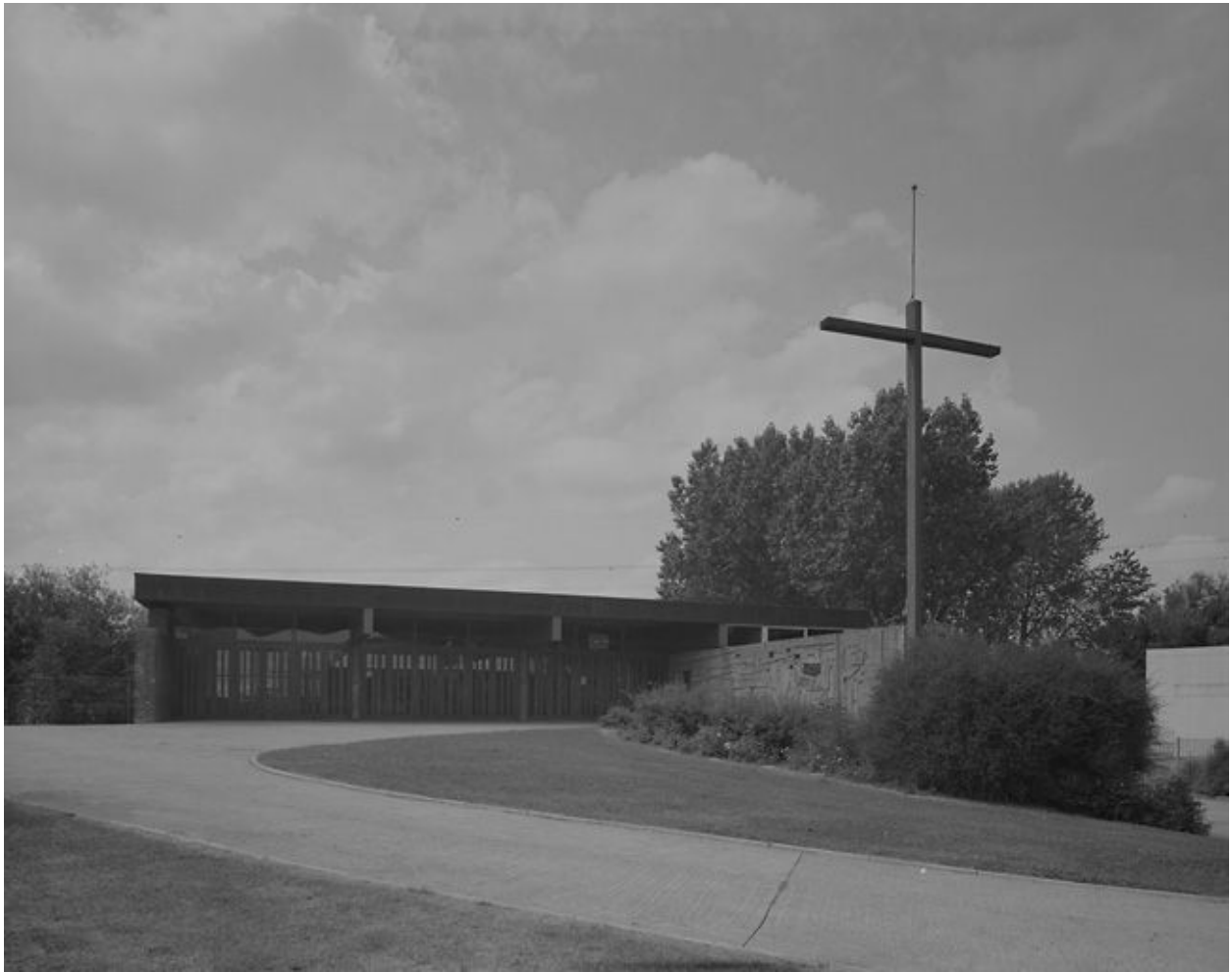
Vue de la façade est.
