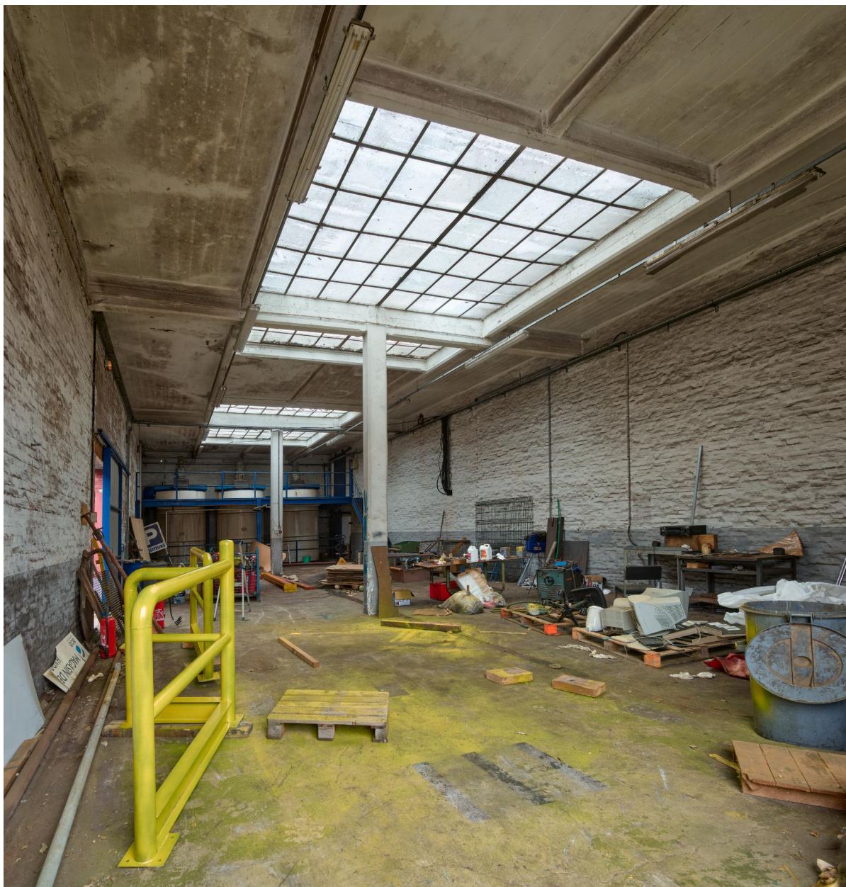
Intérieur des entrepôts (bâtiment E).
