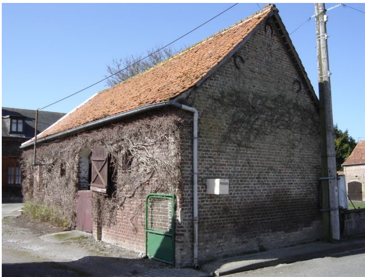
Vue de l'écurie sur rue.
