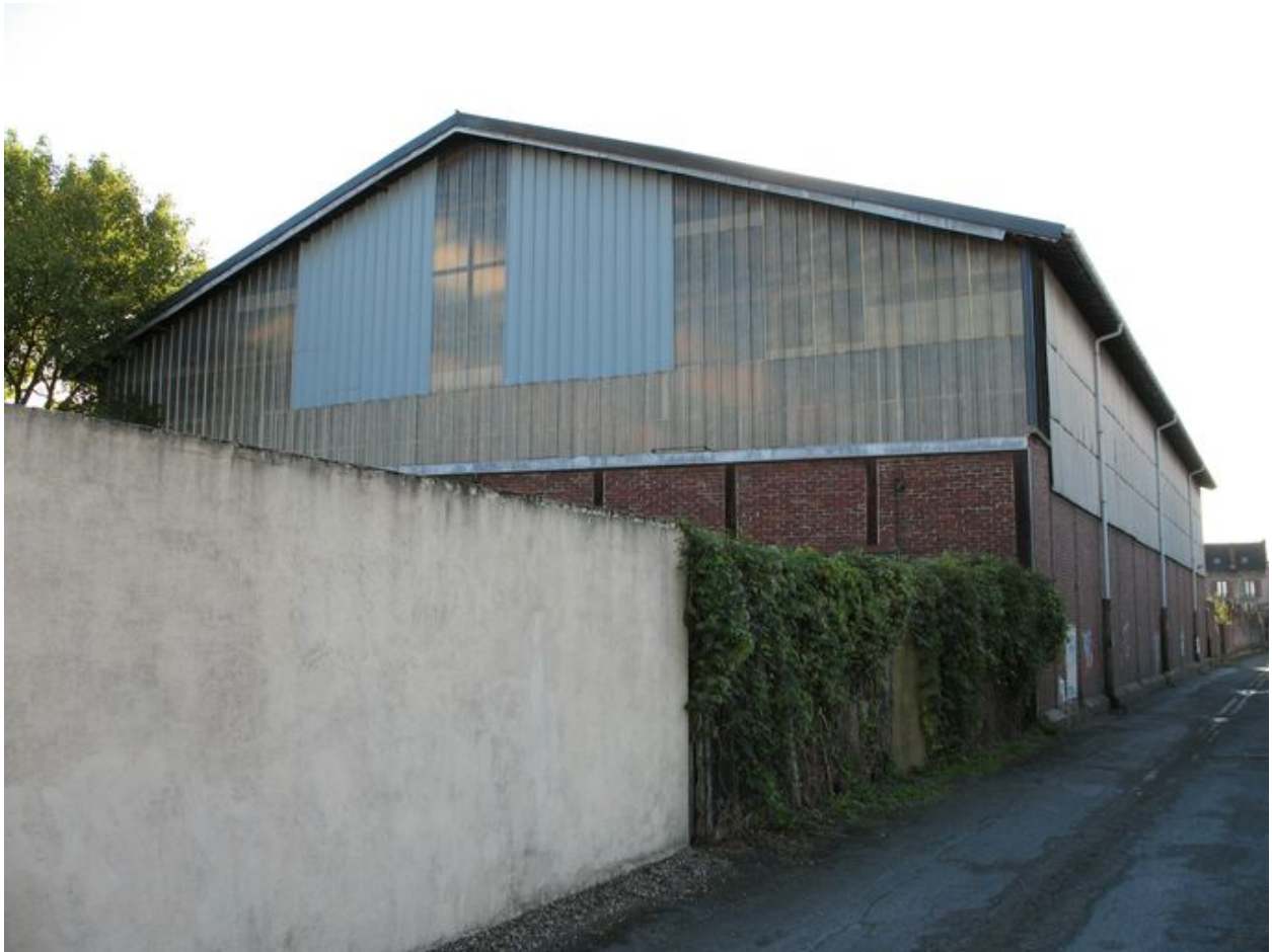
Atelier du parc à matériel depuis la cour des Marais.
