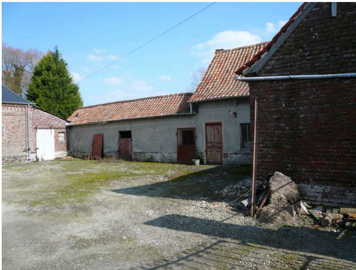
Vue des étables depuis la cour.
