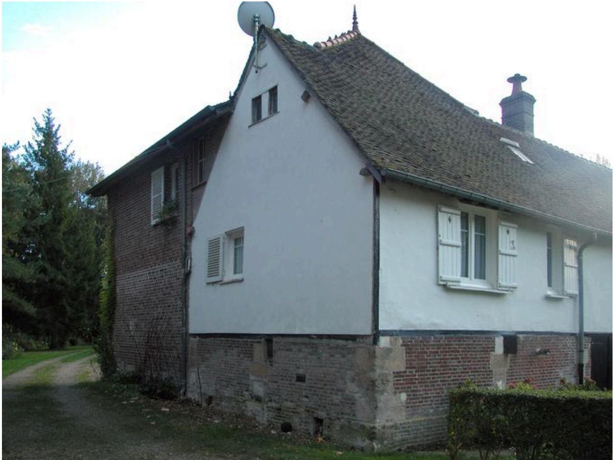
Pignon du logement patronal avec l'adjonction du début du 20e siècle.
