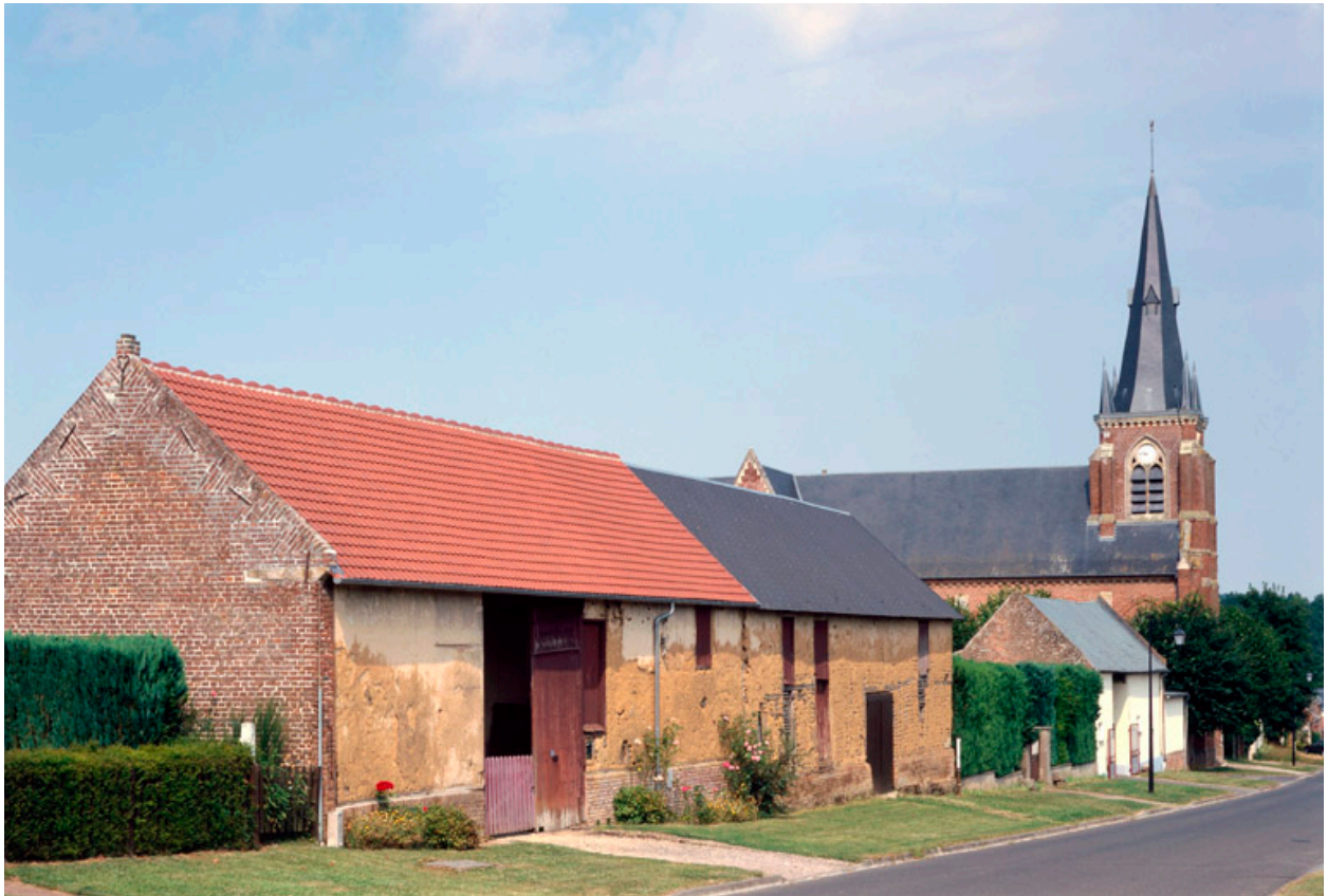
La Grande-Rue avec au premier plan, les granges en torchis des 46 et 44.
