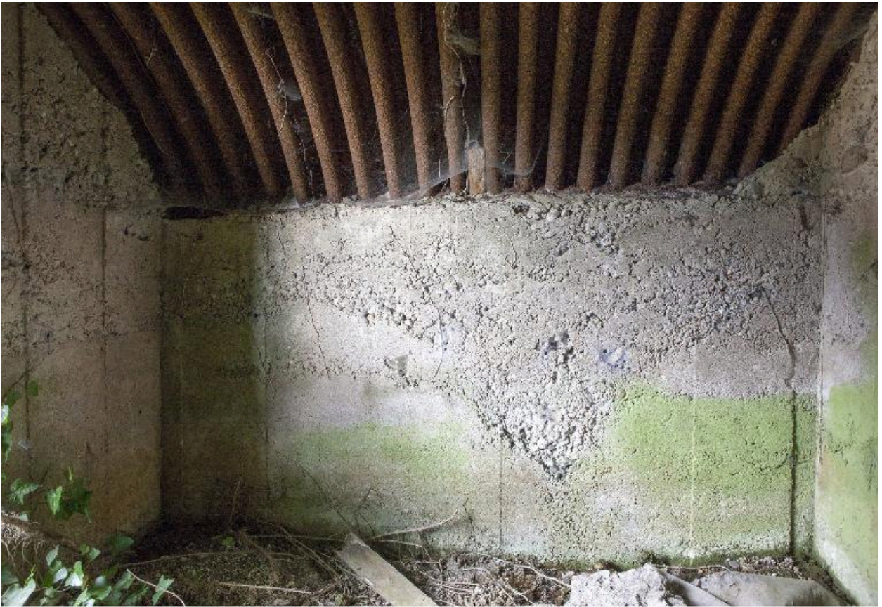
Vue intérieure de la casemate à munitions, probablement celle de la position II sur les document britanniques
