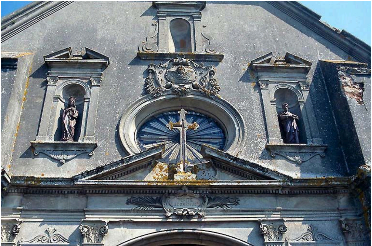
Détail de la partie supérieure du portail occidental.
