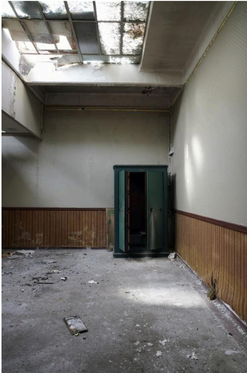
Bureaux, vue intérieure.
