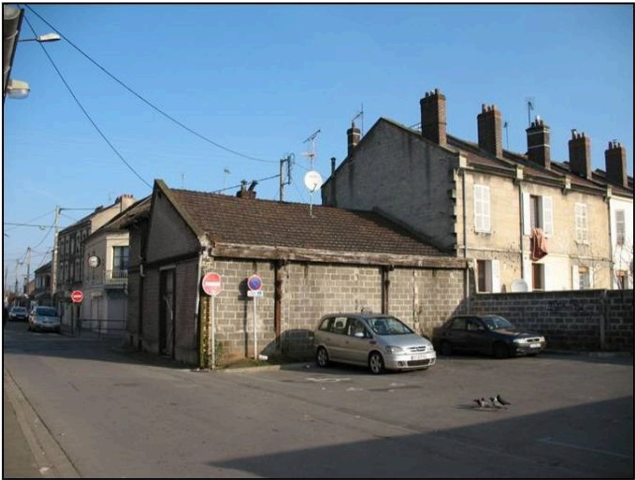
Vue générale de l'emprise de l'atelier et de la dernière travée existante.
