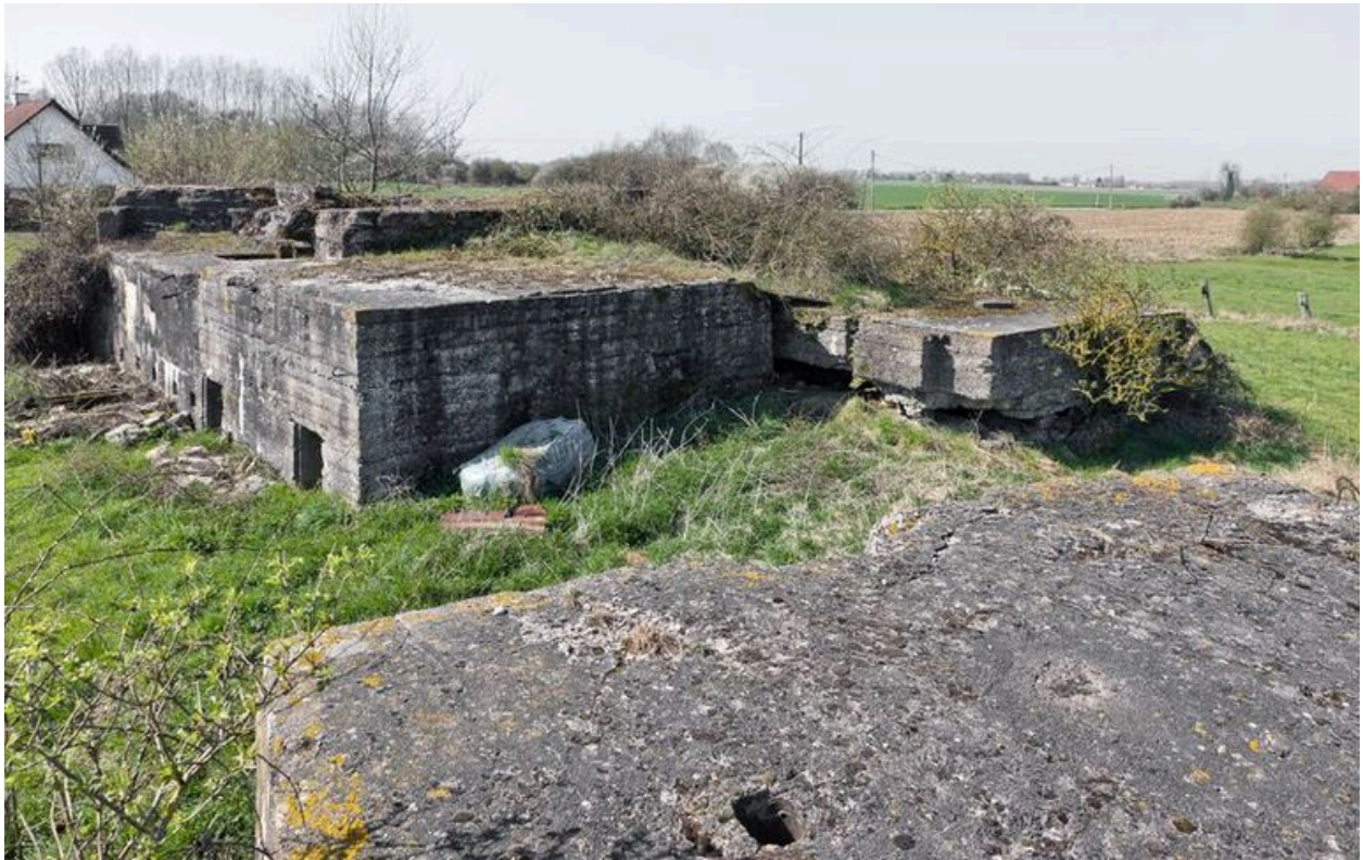
Depuis le toit de la casemate B : La casemate A, vers l'ouest
