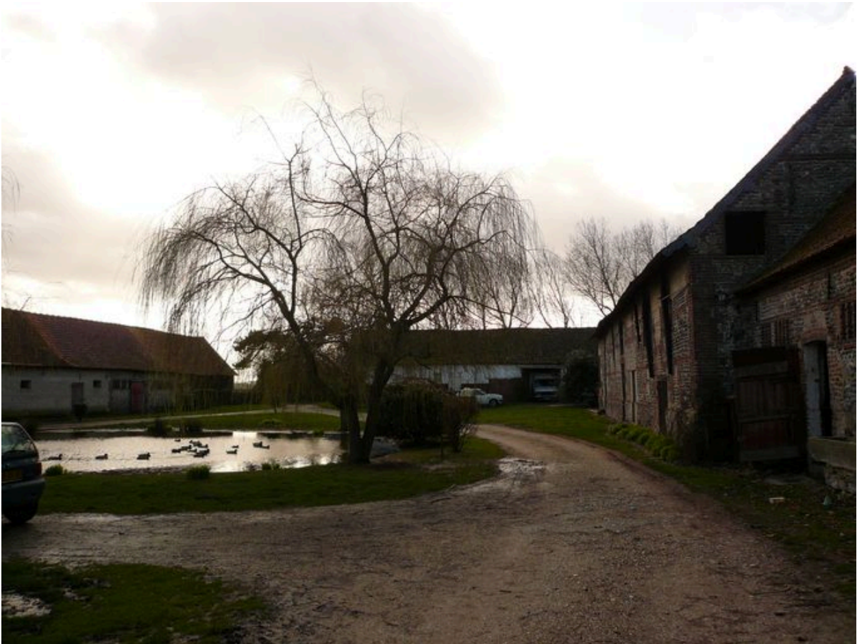
Vue générale des bâtiments depuis le logis au nord.
