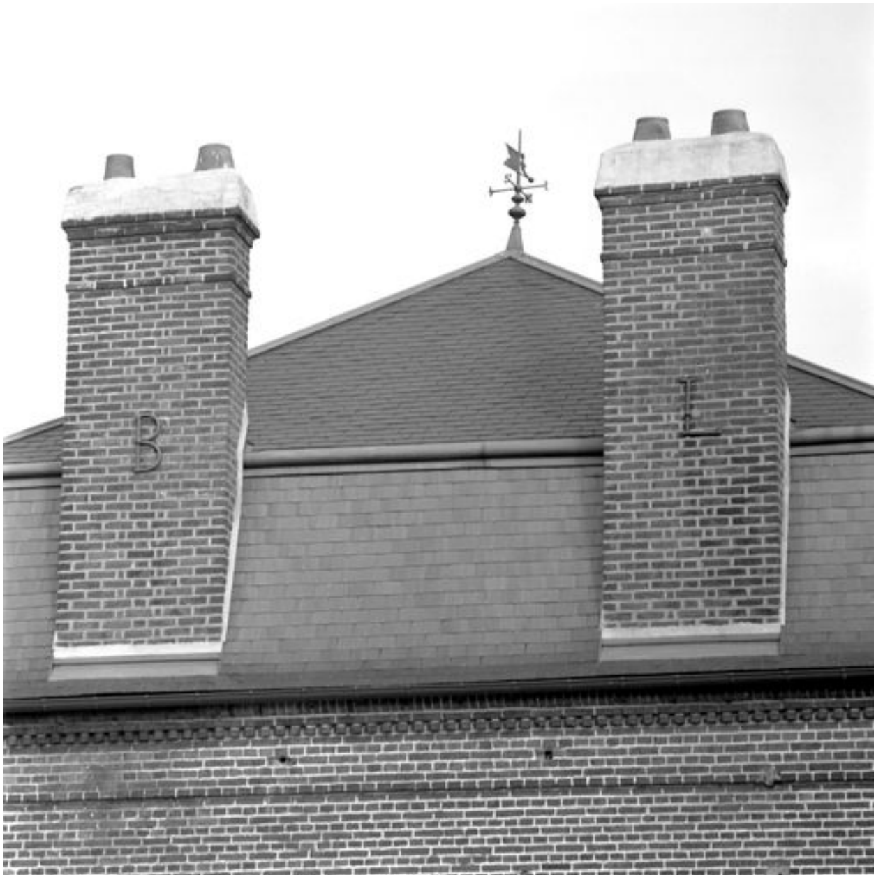
Détails des tirants en fer forgé situés sur les cheminées du logement patronal et figurant les initiales BL, Bollé Letellier.
