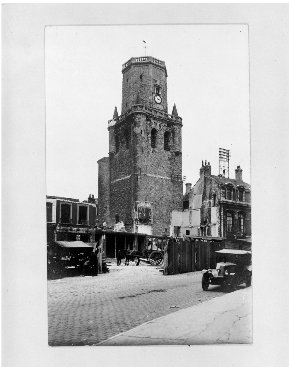
Le beffroi : base en cours de dégagement, carte postale A.D. Pas-de-Calais, division cartes postales.
