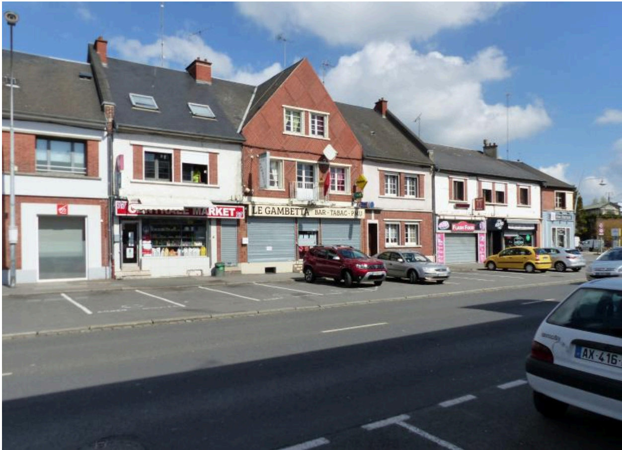
Boulevard Gambetta. Vue du groupe est, 2 à 8 boulevard Gambetta.
