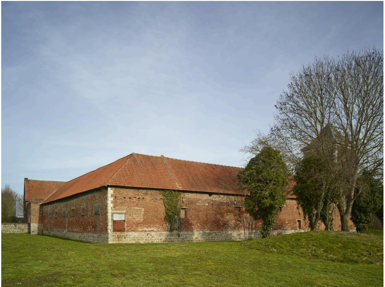
Bâtiments agricoles à l'angle sud-ouest. Vue prise depuis la rue.
