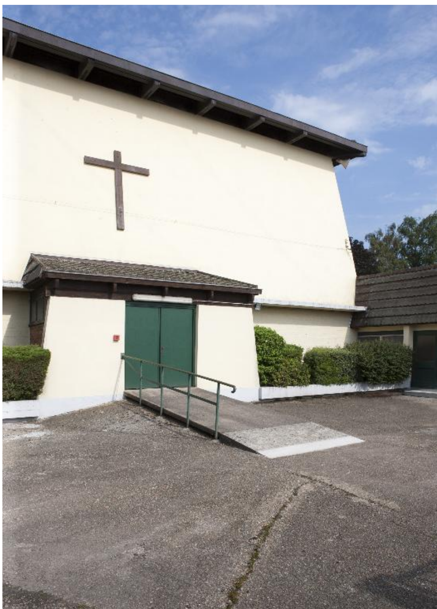
Élévation antérieure de l'église.
