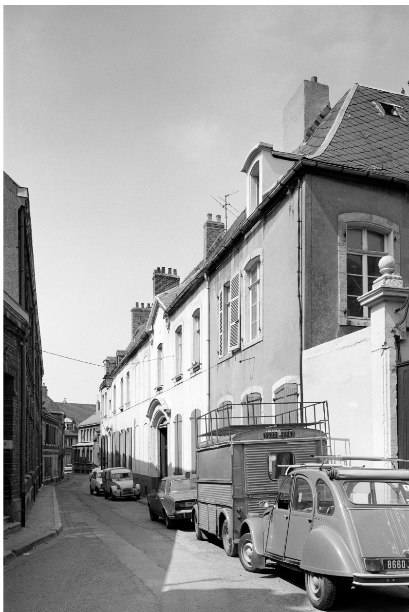
Vue générale sur voie.
