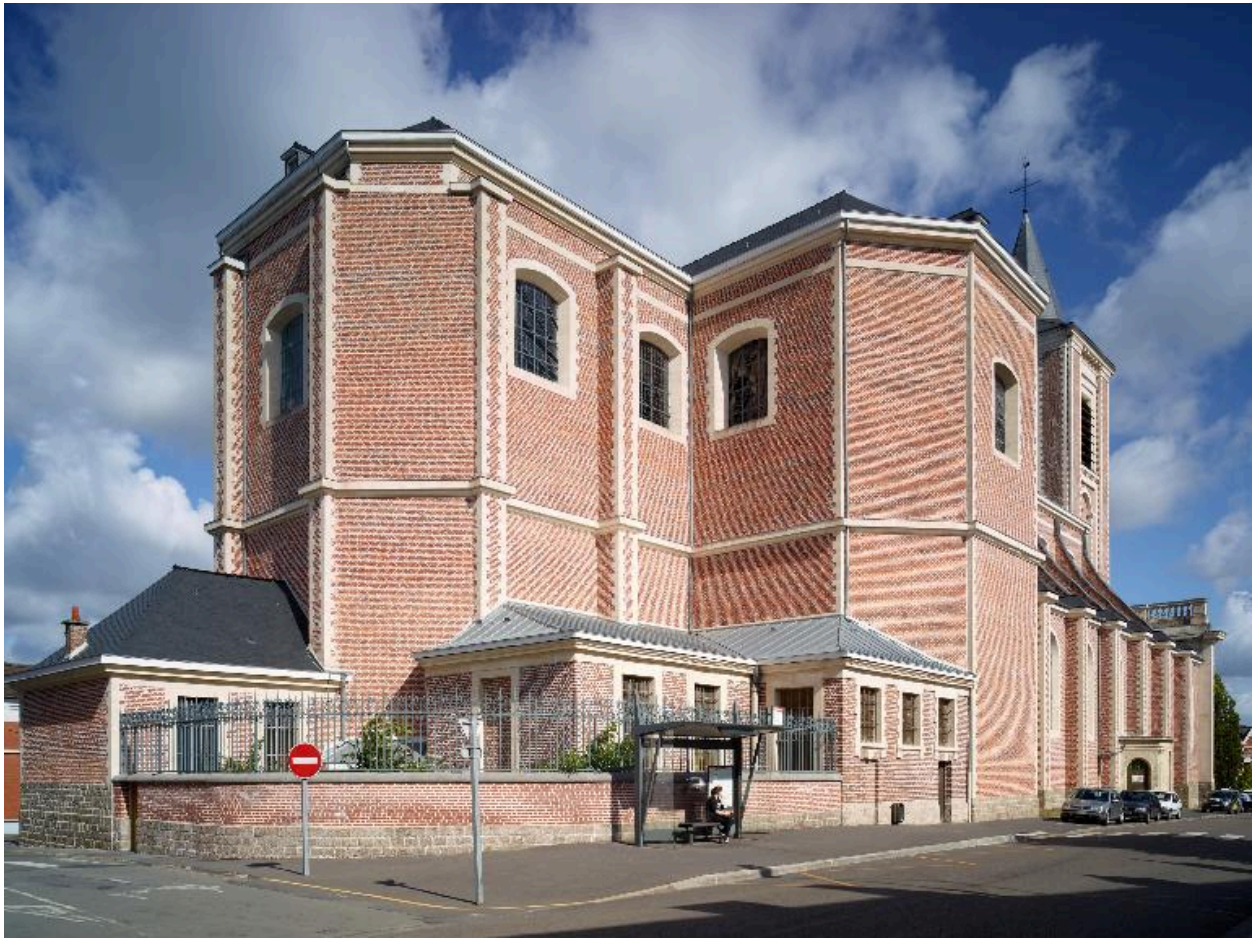
Vue générale extérieure depuis l'abside.
