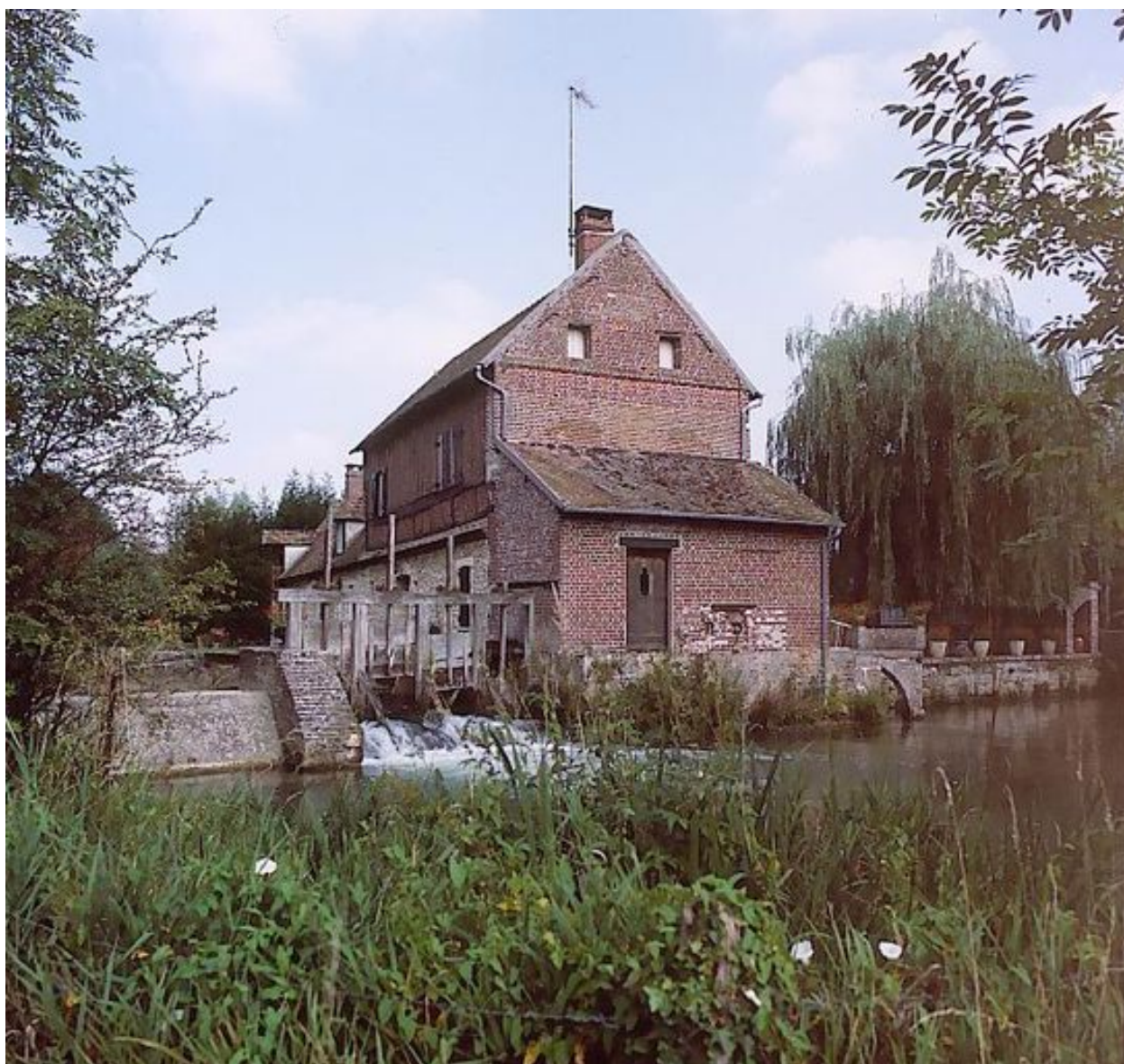
Vue d'ensemble sud-ouest du moulin.
