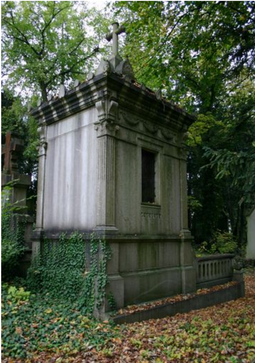
Vue générale postérieure.
