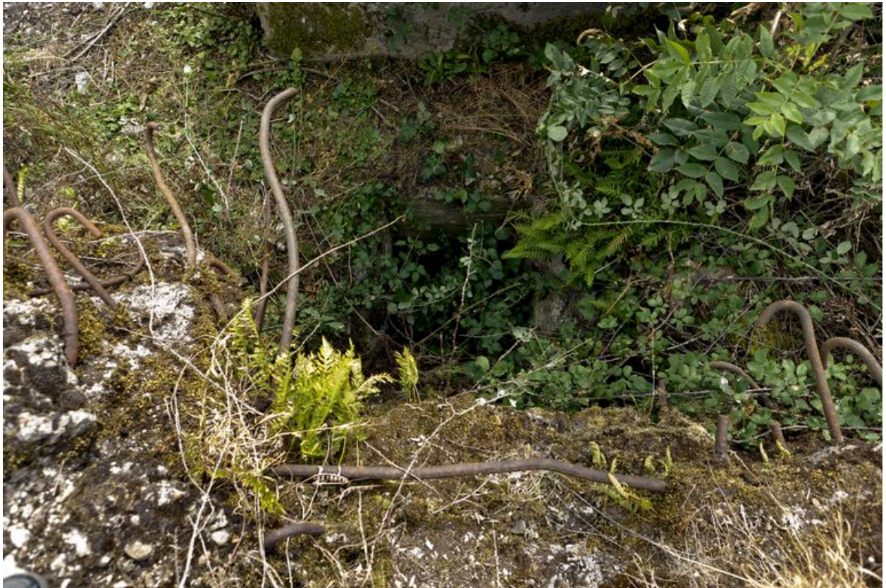
Casemate A. Depuis le couvrement. Débouché de l'accès à la mitrailleuse
