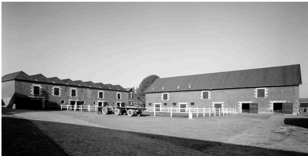
Cour. Vue partielle.
