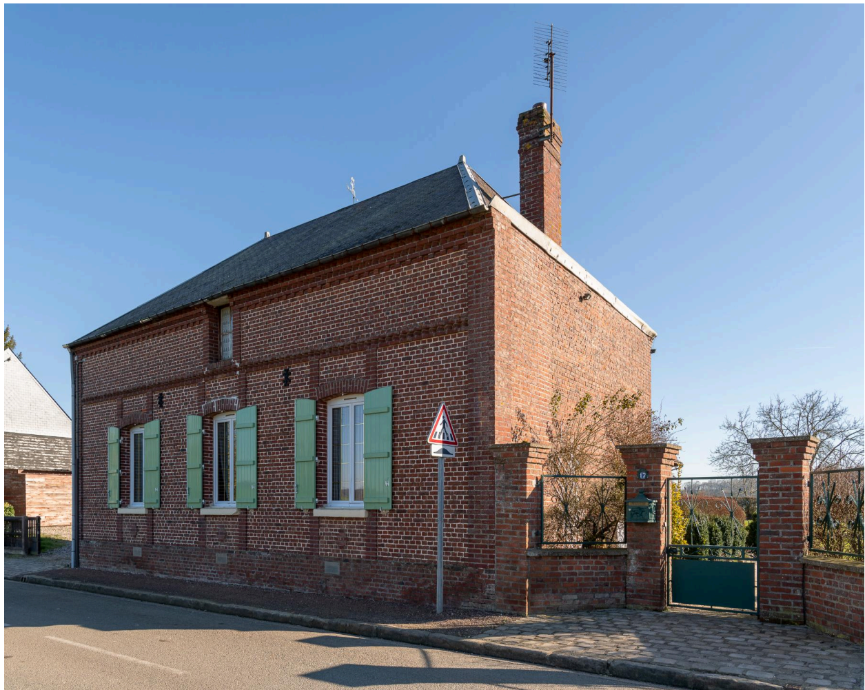
Maison sur rue, n°17 rue de la Chaussée, vue depuis le nord-ouest.
