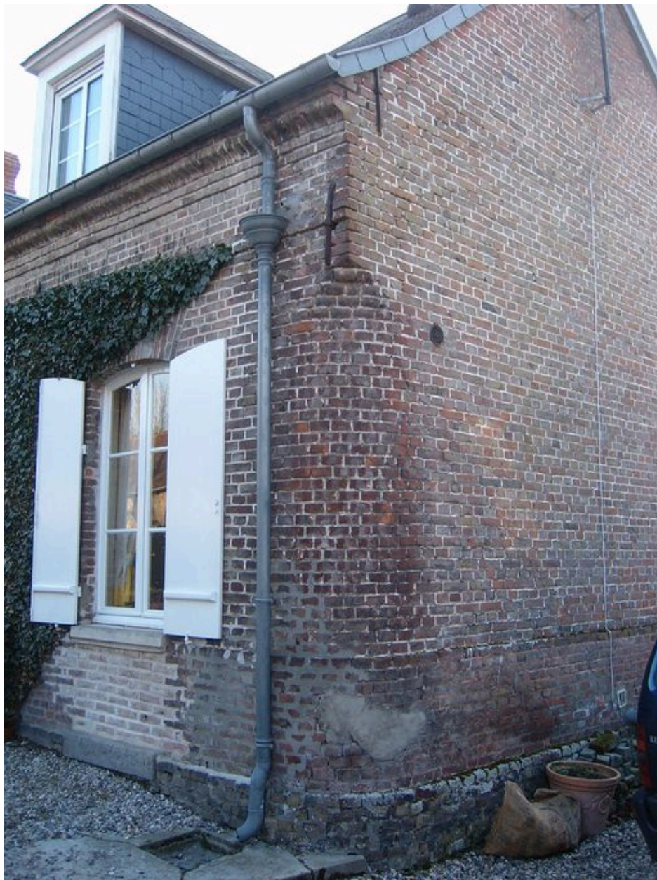
Vue de l'angle nord arrondi de la maison avec encorbellement.
