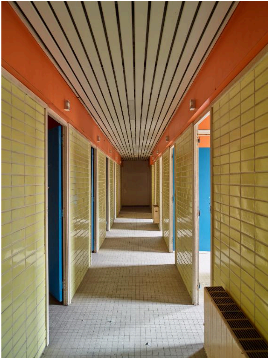
Aile sud, premier étage. Bains de baignoire à prix réduit pour hommes, remaniés. Vue du couloir vers le sud.
