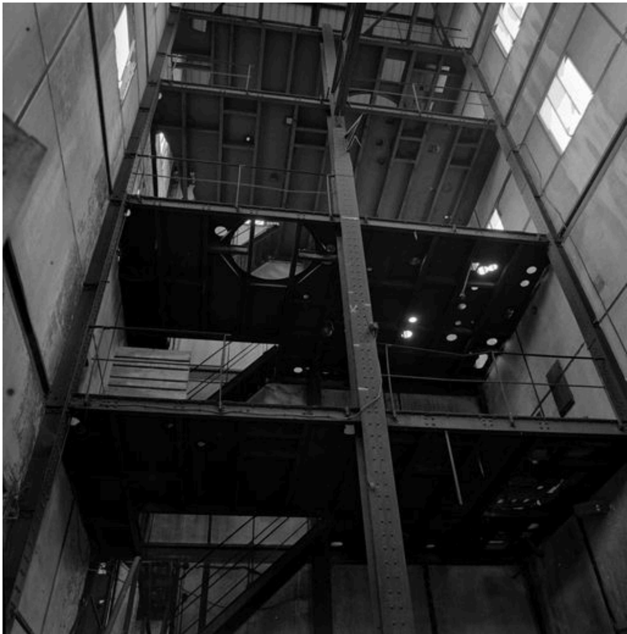
Vue intérieure de la colonne de distillation de 1933.
